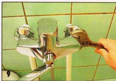
9 Затягивая накидные гайки, нужно не переусердствовать, чтобы не повредить резиновые прокладки. Лучше подтянуть их потом после проверки герметичности соединений, если в том будет необходимость.
