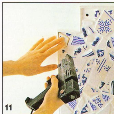
11 Укрывают головки крепёжных шурупов, наклеивая поверх них последние черепки.
