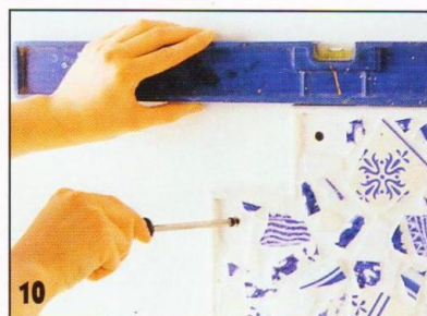
10 Просверлив в стене отверстия, забивают в них дюбели. Крепят шурупами украшенное мозаикой панно.
