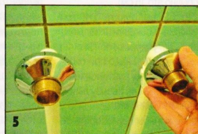
На эксцентрики накручиваем декоративные колпаки.
