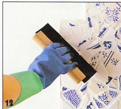
12 В завершение затирают швы в углах панно в местах крепления.
