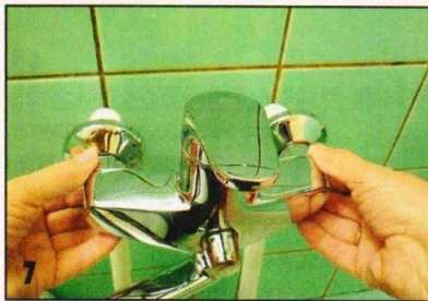
7 Чтобы избежать перекоса при установке смесителя, надо вращать обе накидные гайки одновременно.
