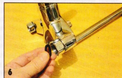
Прежде чем прикручивать смеситель к эксцентрикам, вставляем резиновые прокладки в его накидные гайки.
