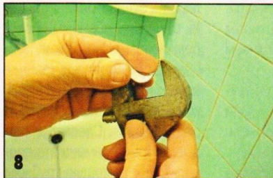
8 Для затяжки накидных гаек смесителя лучше использовать разводной гаечный ключ, чтобы под его губки можно было поместить прокладку из картона.
