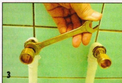
Используя рожковый гаечный ключ, устанавливаем эксцентрики.
