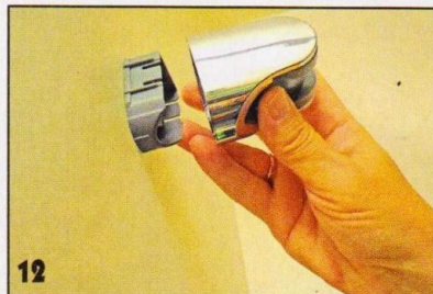
12 Устанавливаем корпус держателя лейки.
